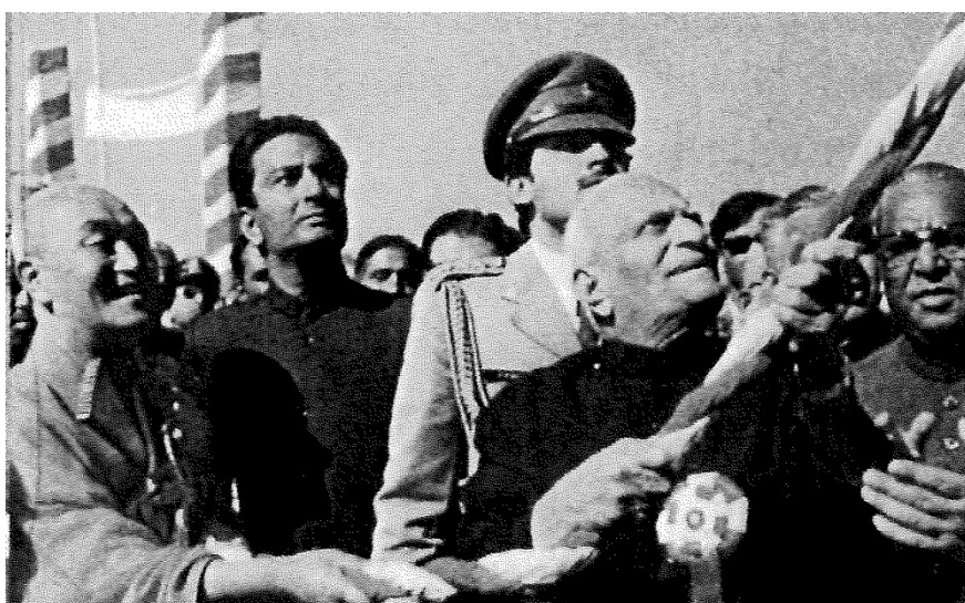
昭和 47 年 11 月本堂工事が順調に進み翌年 12 月、全日仏会長佐藤泰舜猊下、インドの V.V.ギリ大統領を招いて盛大な落慶法要が行われた。
