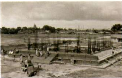
1971年本堂工事が開始、左遠方に大塔大菩提寺を望む
