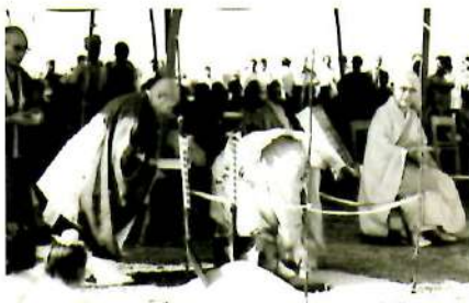
1981年善光寺大本願、一条智光上人による光明施療院起工式での鍬入れ
